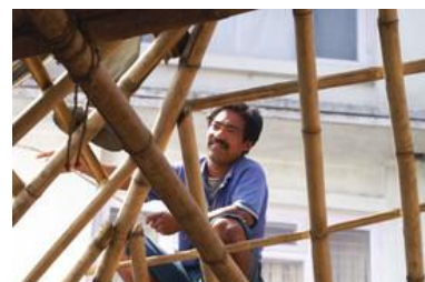
DES TRAVAUX DE RENOVATION ET D'EXTENSION ...
